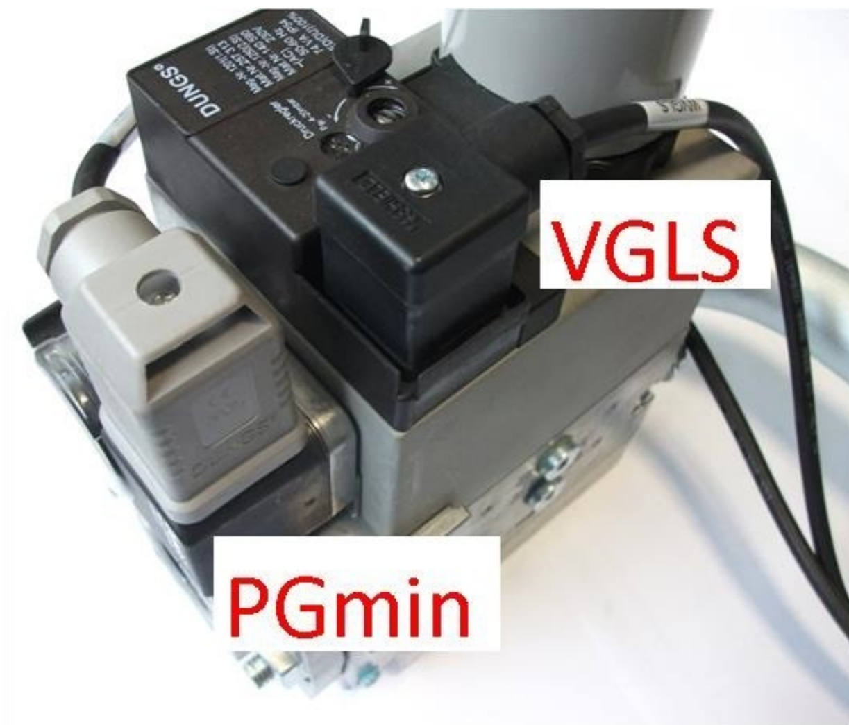
Fig. 2 Электрические соединения к газовой магистрали
