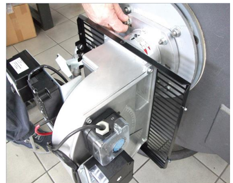
6) Зафиксировать горелки на котел;
