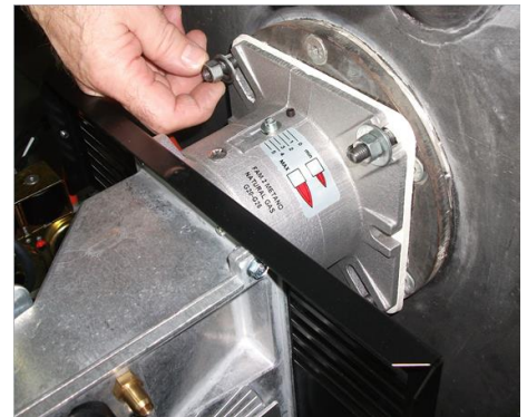
6) Зафиксировать горелки на котел;
