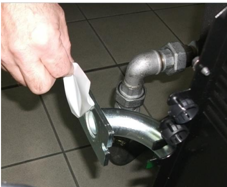
7) Снять заглушку из Труба ГАЗОВОЙ рампы;
