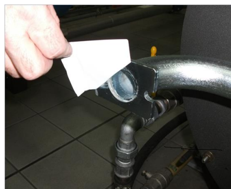
6) Снять заглушку из Труба ГАЗОВОЙ рампы;
