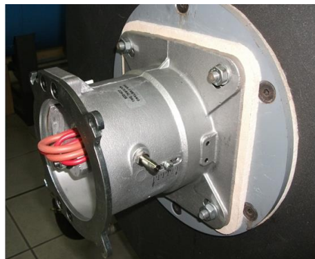
2) Смонтировать Смесительную Группу на котле;
